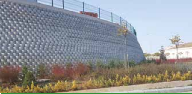
Fabrika ve Havalimanı gibi geniş düz alanların sınır duvarlarında
