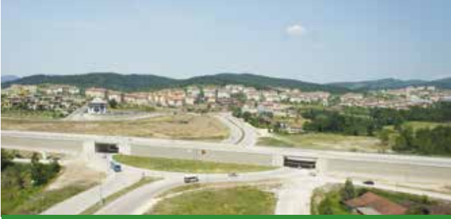
Köprü yaklaşım duvarlarında
