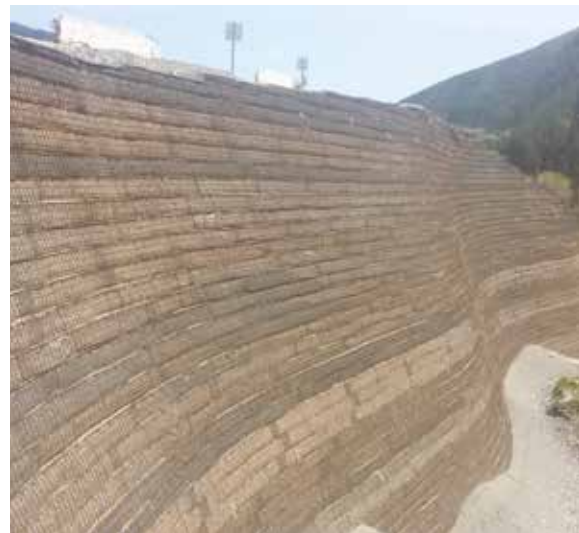
Karayolları 15. Bölge Md. - Ilgaz Tüneli Yaklaşım Yolları
