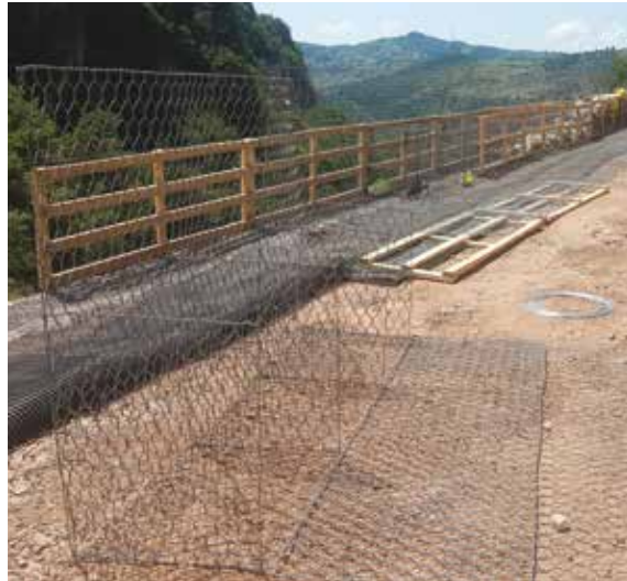
Karayolları 15. Bölge Müdürlüğü – Bartın Arıt Yolu
