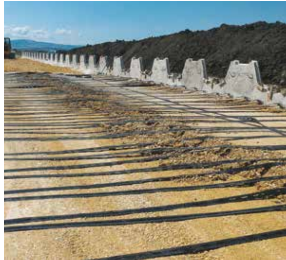
Karayolları 14. Bölge Md. – Gölkiyı Kavşağı Projesi
